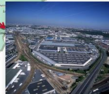
Plate-forme multimodale Sogaris de Rungis Porte d'entrée logistique de la région Ile-de-France
