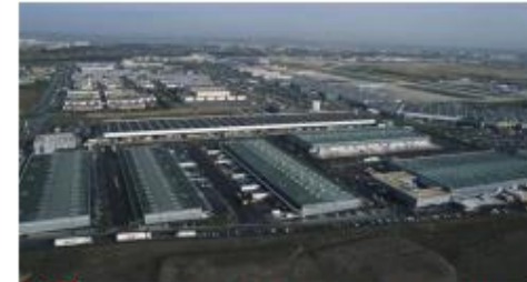
Plate-forme Sogaris de Roissy Aéroport international de Roissy Charles-de-Gaulle
